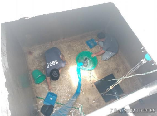
ล้างทำความสะอาดถังเก็บน้ำสำรองของโครงการ ภาพที่ 2.2-9 (ต่อ) การสำรองน้ำใช้ภายในโครงการ
