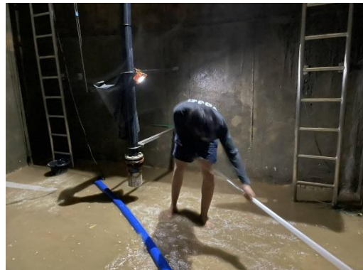
ล้างทำความสะอาดถังเก็บน้ำสำรองของโครงการ ภาพที่ 2.2-9 (ต่อ) การสำรองน้ำใช้ภายในโครงการ
